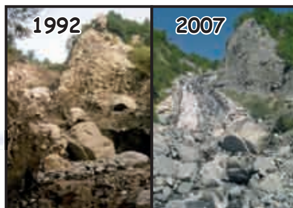
Le Nant Bordon au niveau de sa confluence avec l'Arve. En 1992, après une crue important qui avait causé des dégâts sur la commune. En 2007, après la mise en place de seuils dans le lit du cours d'eau afin d'éviter les phénomènes de ravinement et de laves torrentielles
