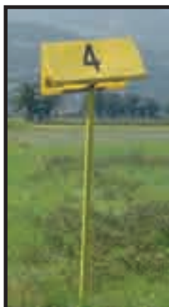
Balise signalant la présence d'une canalisation de transport de gaz à haute pression
