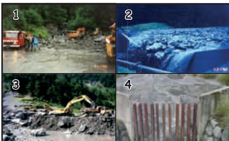
La crue du Nant Bordon, le 20 juillet 1992 :
