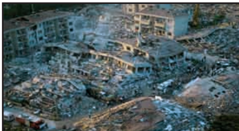
La ville de Gölcük (épicentre du séisme, intensité X) après le séisme de magnitude 7,9 qui a frappé la région d'Izmit (Turquie), le 17 août 1999. Ce séisme a provoqué la mort d'au moins 15 500 personnes, et l'effondrement partiel ou total de 50 000 immeubles (cliché : Yann Arthus-Bertrand)
