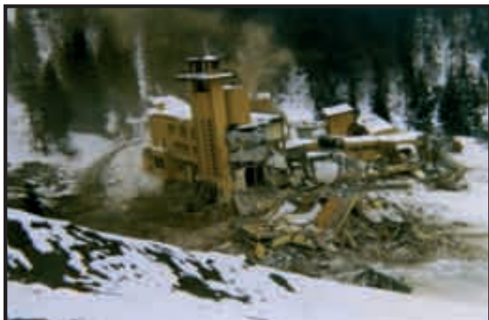
Le sanatorium du Roc des Fiz après le passage de la coulée de boue qui fit 72 victimes (avril 1970)
