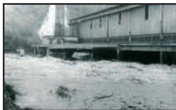
Débordement des eaux de crue en rive droite de l'Arve sur le site de l'usine de Chedde le 22 septembre 1968. Les eaux ont envahi les bâtiments de l'usine et inondé la localité de Chedde
