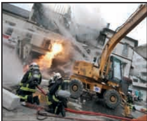
Les pompiers face au feu après l'explosion d'une conduite de gaz à Bondy (Seine Saint Denis) le 30 octobre 2007. Cet accident a provoqué la mort d'une personne et fait 40 blessés dont 9 graves (Cliché : Rémi Dussert/AFP)
